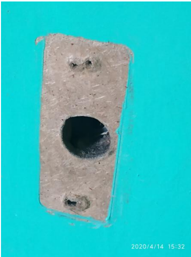
Отсутствуют дверные ручки
