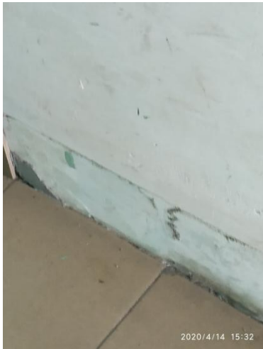
Отсутствие половой плитки/плинтуса
